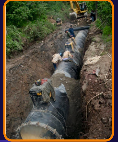
Arsan Enerji A.Ş. Araklı Hes Projesi İletişim Hattı Sifon Sistemli İ1420x8 Çap Bir Bölüm Kanalda Görünüş
