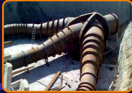
Arsan Enerji A.Ş. Araklı Hes Projesi İletişim Hattı Sifon Sistemli İ1420x8 Çap Bir Bölüm Kanalda Görünüş
