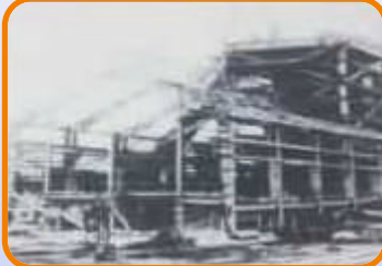
Sanselki Gübre Fabrikası İnşaatı
