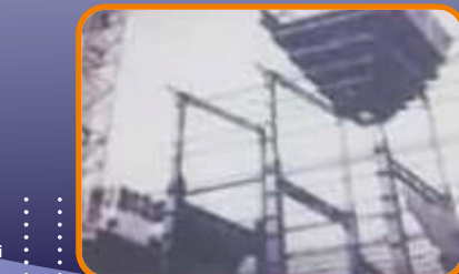
İskenderun Demir Çelik Fabrikası Sinter Ünitesi (1978)
