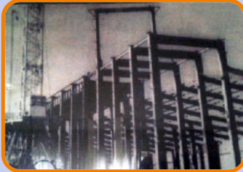
Çayırhan Termik Santrali
